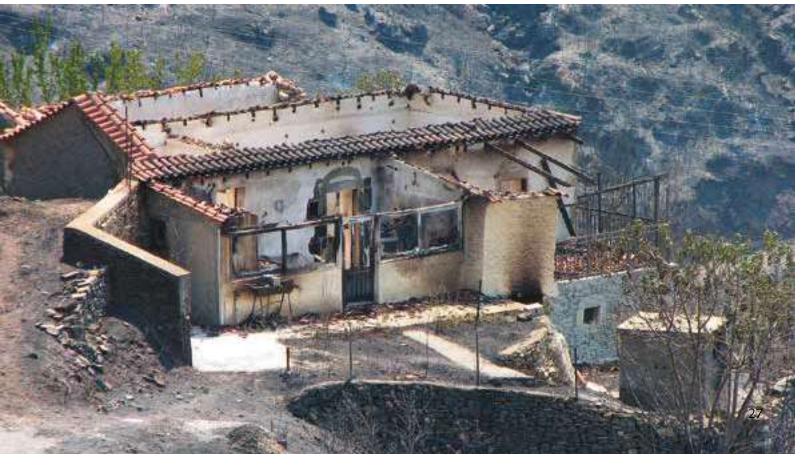
Εικόνα 2: Το πισσόχαρτο κάτω από τα κεραμίδια μιας ξύλινης στέγης συνιστά σοβαρή αδυναμία και αυξάνει δραματικά την πιθανότητα καταστροφής ενός σπιτιού, αν προσγειωθούν καύτρες εκεί.
